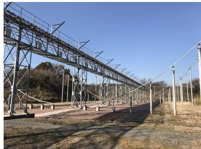
**名古屋大学の大型電波望遠鏡**：開口面積約4000m<sup>2</sup>の日本最大級の電波天文観測用望遠鏡。観測帯域327MHz。フェーズドアレイ方式で約200本のダイポールの信号を合成している。
